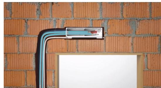
L'operatore può procedere ora con l'inserimento della sonda all'interno del tubo corrugato fino alla fuoriuscita dalla parte opposta.
